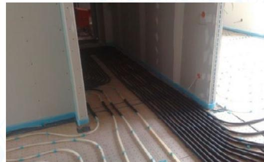
Diese Schutzrohre sind an der Schlitzung überlappend. Dies verhindert das Eindringen von Ausgleichsmasse bzw. Fließestrich in den Hohlraum zwischen Rohr und Schutzrohr. Ein einzigartiges Merkmal im Heizungsbereich.
