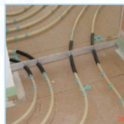
Schutzrohr bei Biofaser Lochplatte
